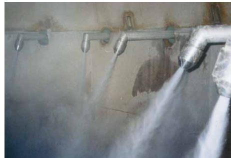
Bild 2: Verdampfungskühler - Innenansicht
